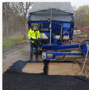
Udlægning med sprider.
