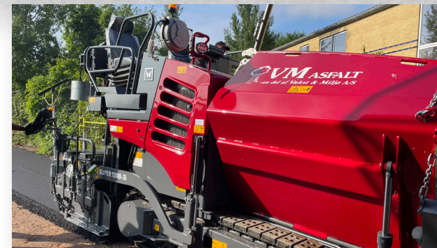
VM Asfalt råder over materiel til alle slags asfaltopgaver.
