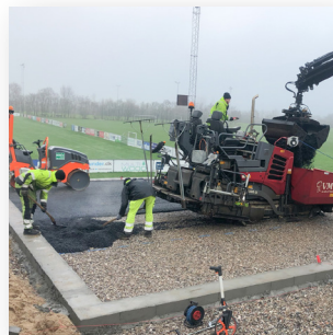
Etablering af padelbane.
