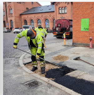
Lukning efter nedgravning af kabler.
